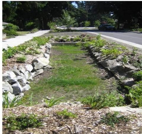
**Figura 7-5:** Trincheira de infiltração.
