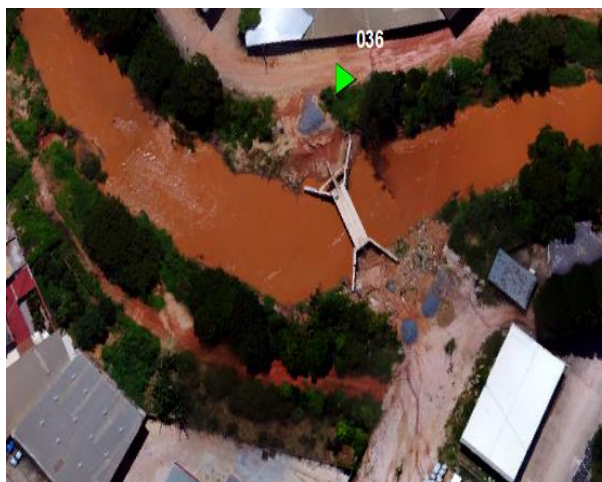
Figura 6-25 - Imagem aérea da região de desmoronamento de ponte – Coordenadas UTM 235.537E / 7.747.116S
