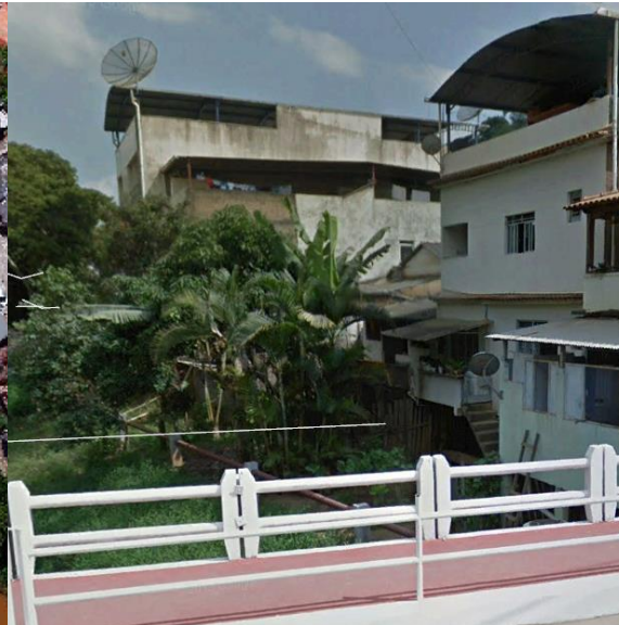
Figura 6-21 - Trecho do rio com edificações sobre a área de inundação do rio Pardo – Coordenadas UTM 235.059E / 7.748.208S
