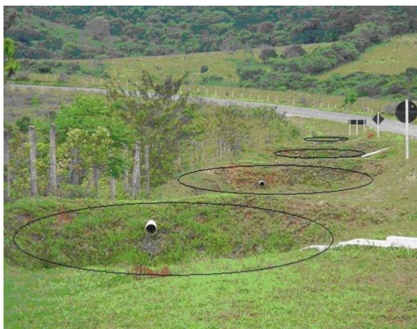
Figura 3-3: Bacias de contenção instaladas às margens de rodovia pavimentada.
