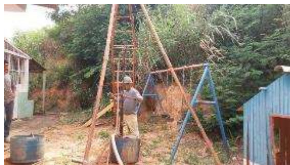
Execução do furo SPT-04.
