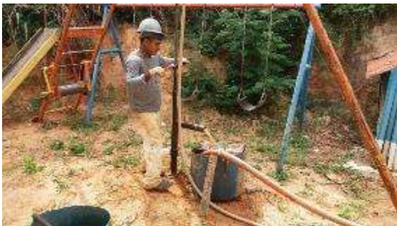
Execução do furo SPT-04.
