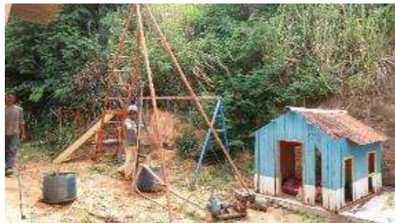
Execução do furo SPT-04.
