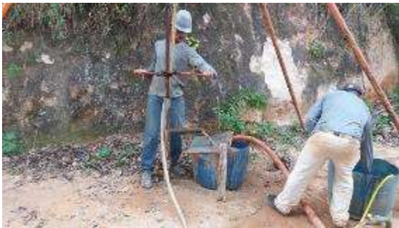
Execução do furo SPT-03.
