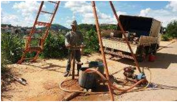
Execução do furo SPT-02.
