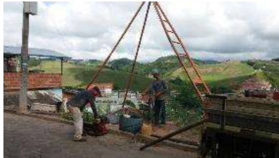
Execução do furo SPT-01.
