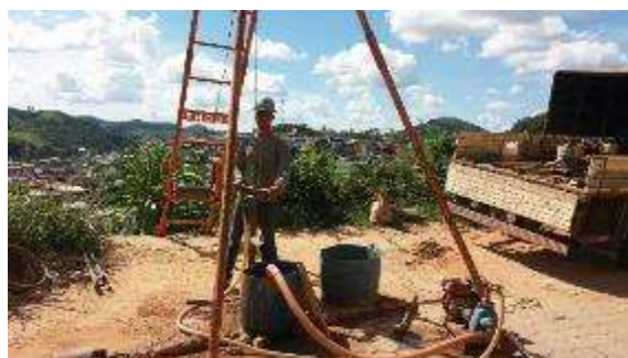
Execução do furo SPT-02.
