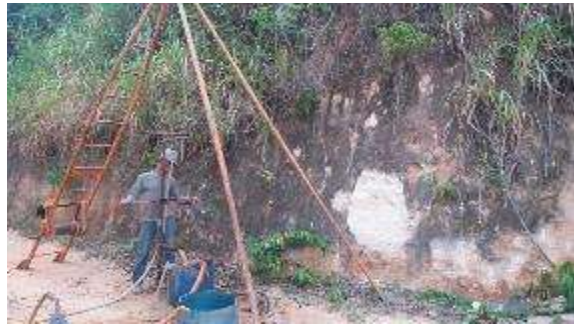
Execução do furo SPT-03.
