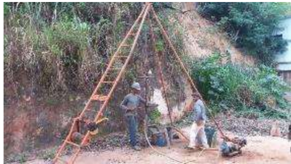
Execução do furo SPT-03.
