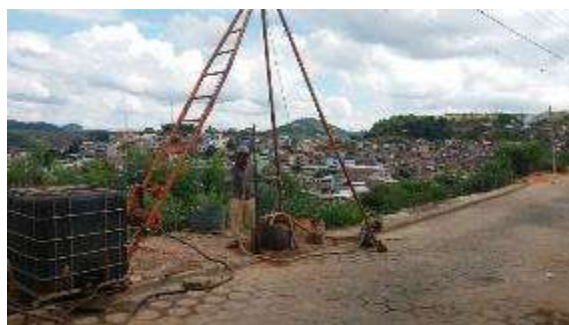
Execução do furo SPT-01A.
