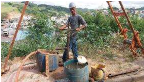
Execução do furo SPT-01.
