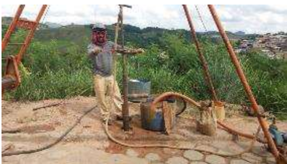
Execução do furo SPT-01A.
