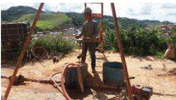
Execução do furo SPT-02.
