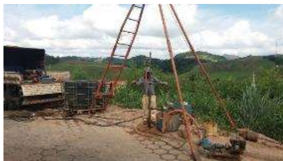
Execução do furo SPT-01A.
