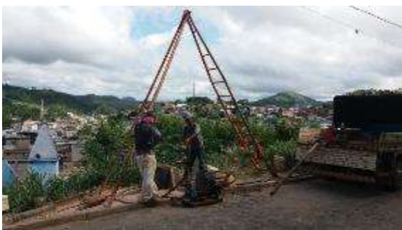
Execução do furo SPT-01.
