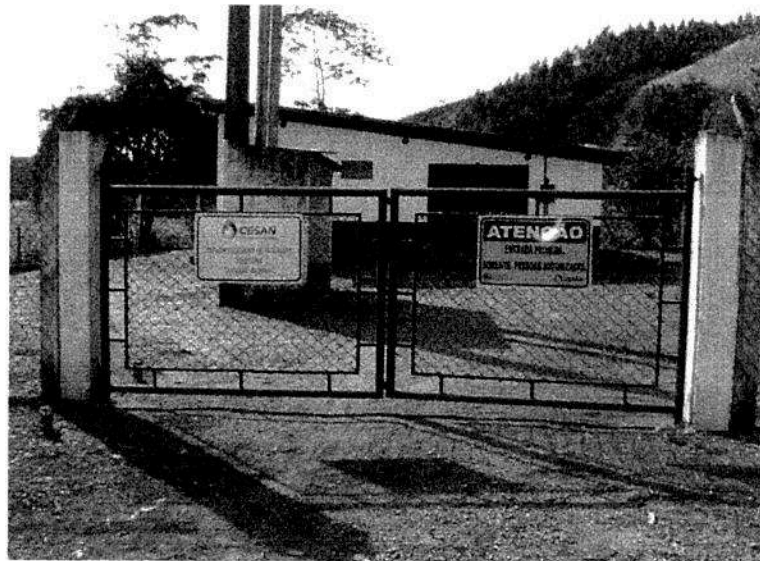
Figura 14: Estação Elevatória de Água Bruta.
