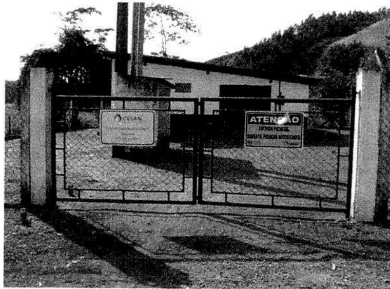
Figura 14: Estação Elevatória de Água Bruta.
